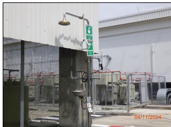
รูปที่ 2.25 อุปกรณ์ชำระล้างฉุกเฉิน (Emergency Shower and Eye Wash Fountain)
