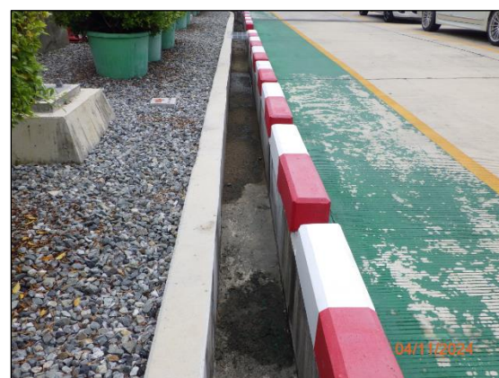
รูปที่ 2.17 ระบบระบายน้ำฝนภายในพื้นที่โครงการ
