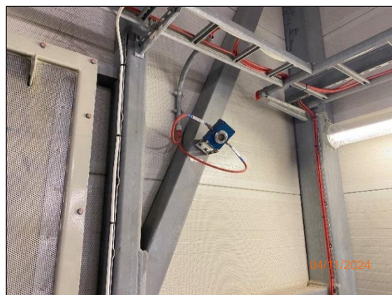
รูปที่ 2.22 ระบบตรวจจับก๊าซ (Gas Detector)
