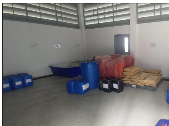
รูปที่ 2.13 พื้นที่จัดเก็บสารเคมีที่มีช่องระบายอากาศ
