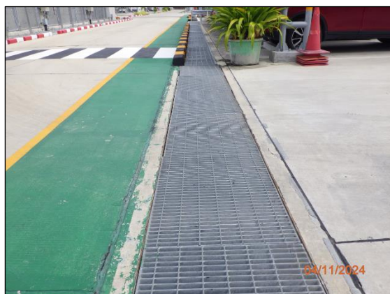
รูปที่ 2.17 ระบบระบายน้ำฝนภายในพื้นที่โครงการ
