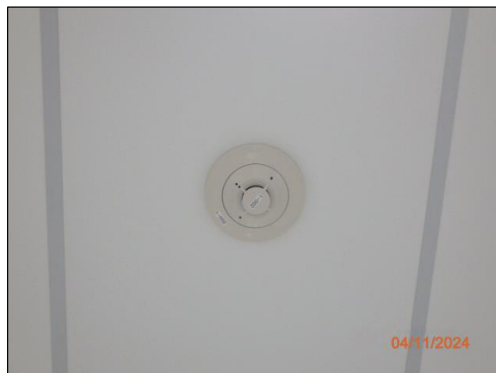
รูปที่ 2.35 การติดตั้ง Smoke Detectors
