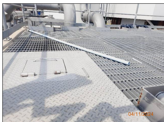
รูปที่ 2.9 บ่อตรวจสภาพน้ำ (Inspection Manhole)
